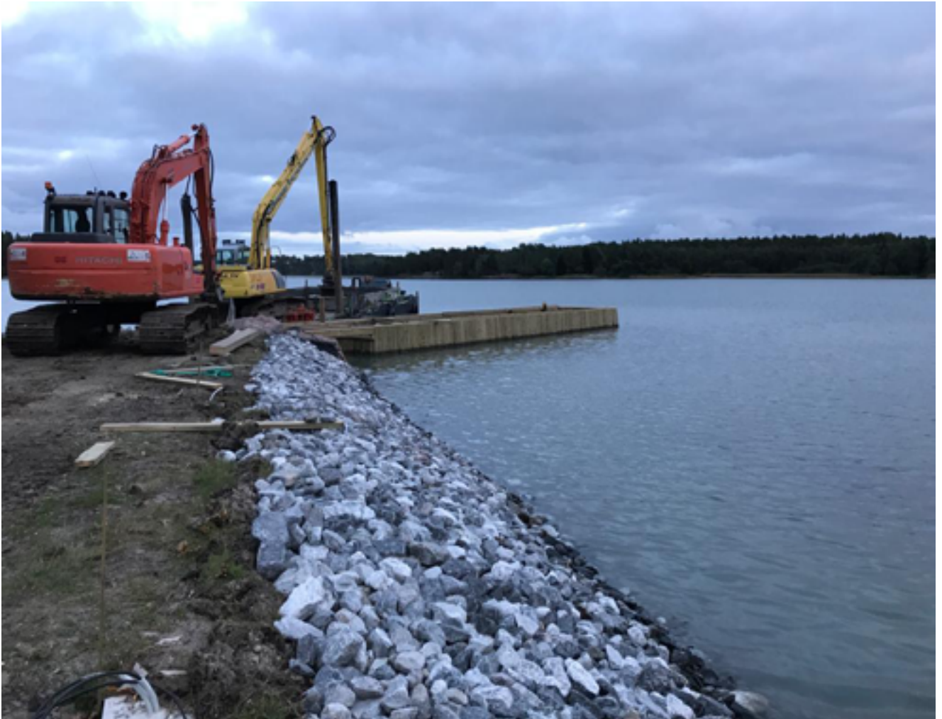
Ruoppaustyö toteutetaan useimmiten kaivinkoneella. Kuva: Vesa Vaihi, Naantalin ranta- ja maanrakennus Oy.
