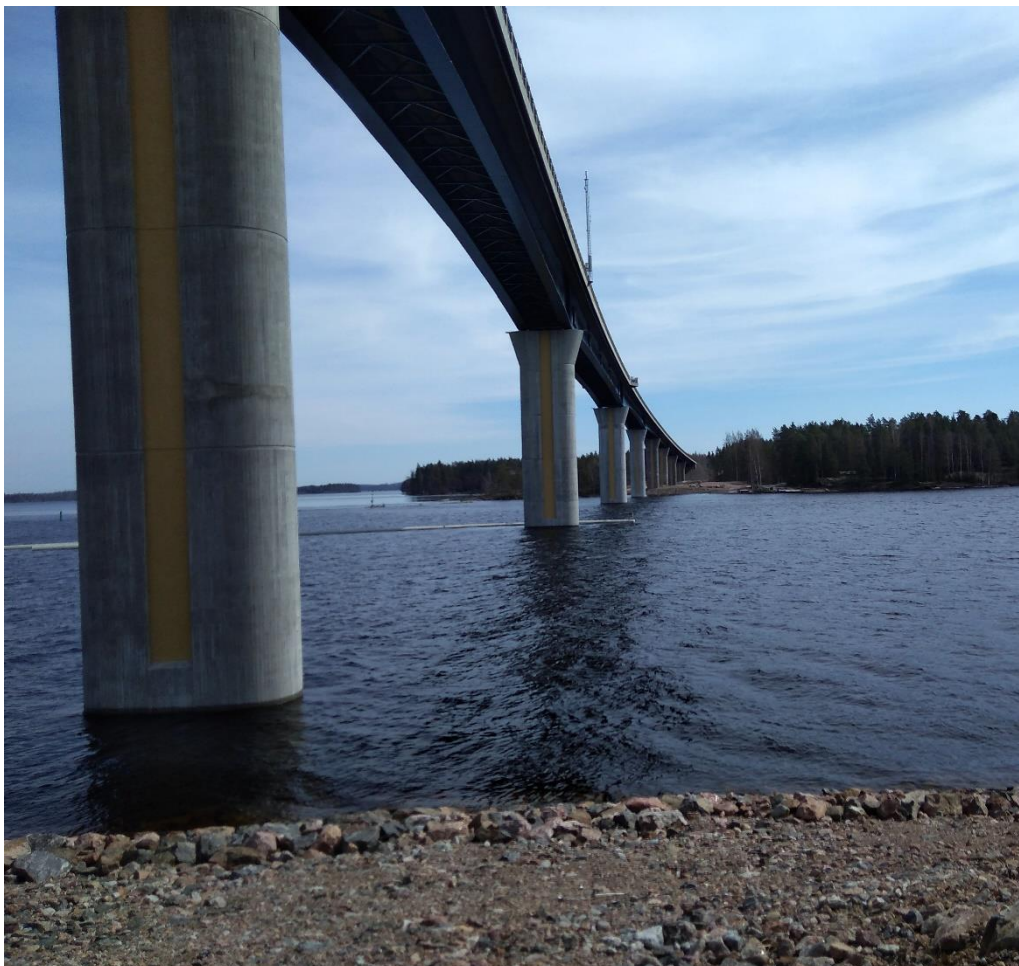
Kuvassa uusi Vekaransalmen ylittävä silta 7/2021
