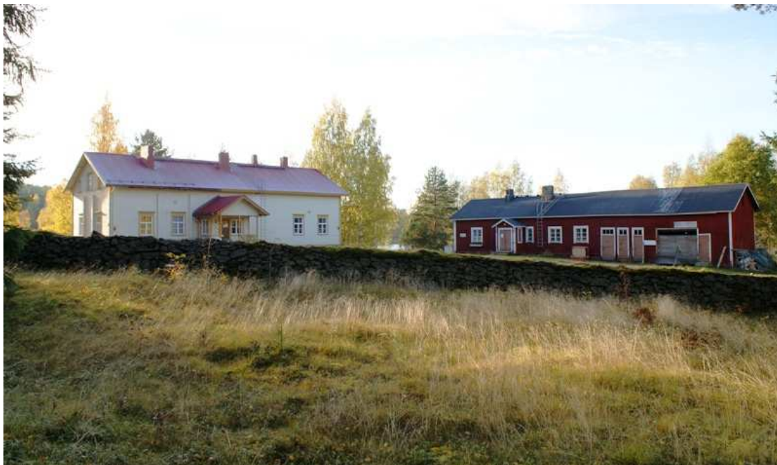
Vanhat hallintorakennukset kuvattuna kirkkomaan kiviaidan takaa. Vanhempaa rakennusta on jatkettu pohjoispäädystä liiteri- ja ulkokuonetiloilla.
