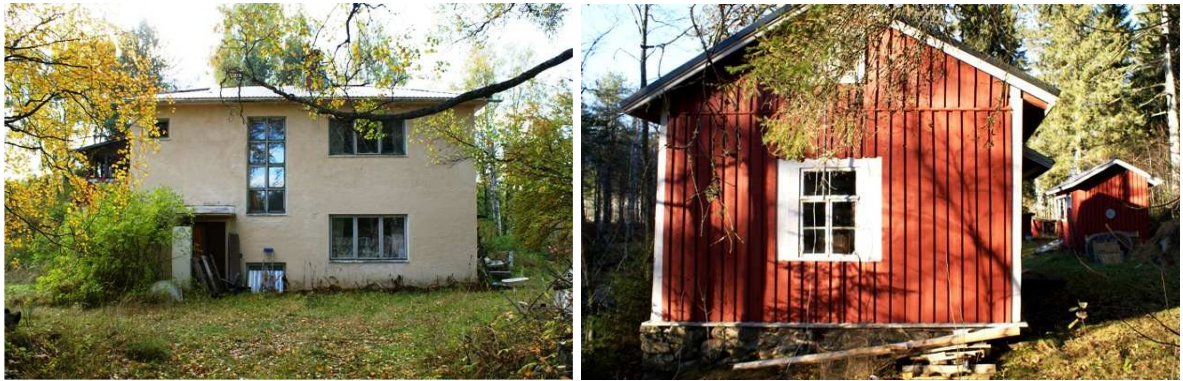
Päivärannan rapattu tiilitalo, jonka kunto on heikentynyt käytön puutteessa. Oikeanpuoleisessa kuvassa on Törönmökki.
