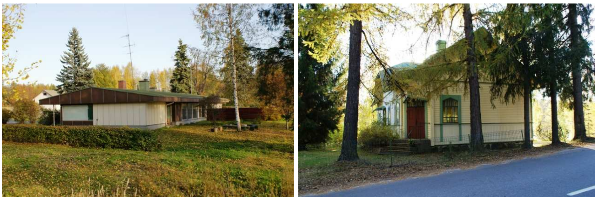
Kuvassa on kirkkoherran asuin- ja viristorakennukseksi rakennettu moderni asuintalo. Sen taakse jää toinen samanlainen talo, joka rakennettiin kanttorin ja seurakuntasisaren asunnoiksi. Oikeanpuoleisessa kuvassa on tyylipiirteiltään hyvin säilynyt Pankinniemen asuintalo.
