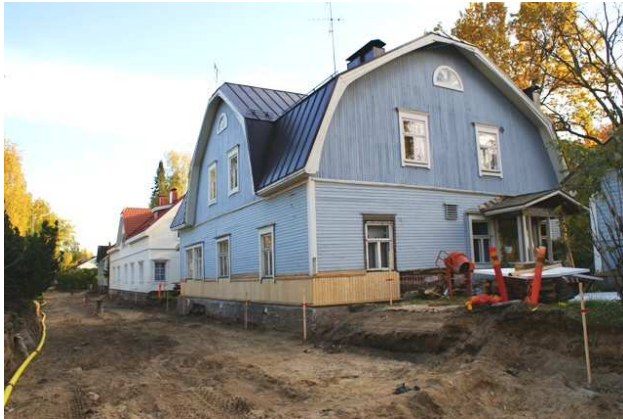
Alanteentietä korjattiin syksyllä 2010.
