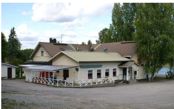
Suojatalon laajennusosa sisäpihalla.
