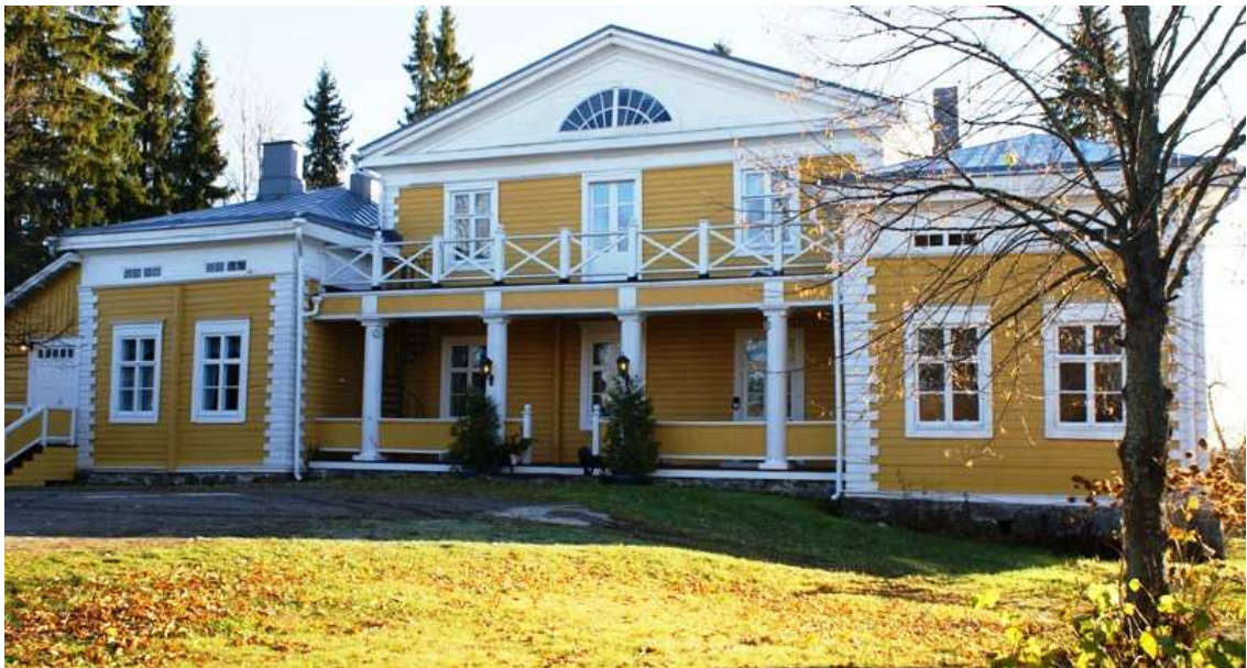
Tiittalan päärakennus on rakennettu majuri Reiherin aikana.
